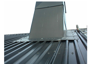
Er taket tilgjengelig bør du sjekke om det ser tett og helt ut.
